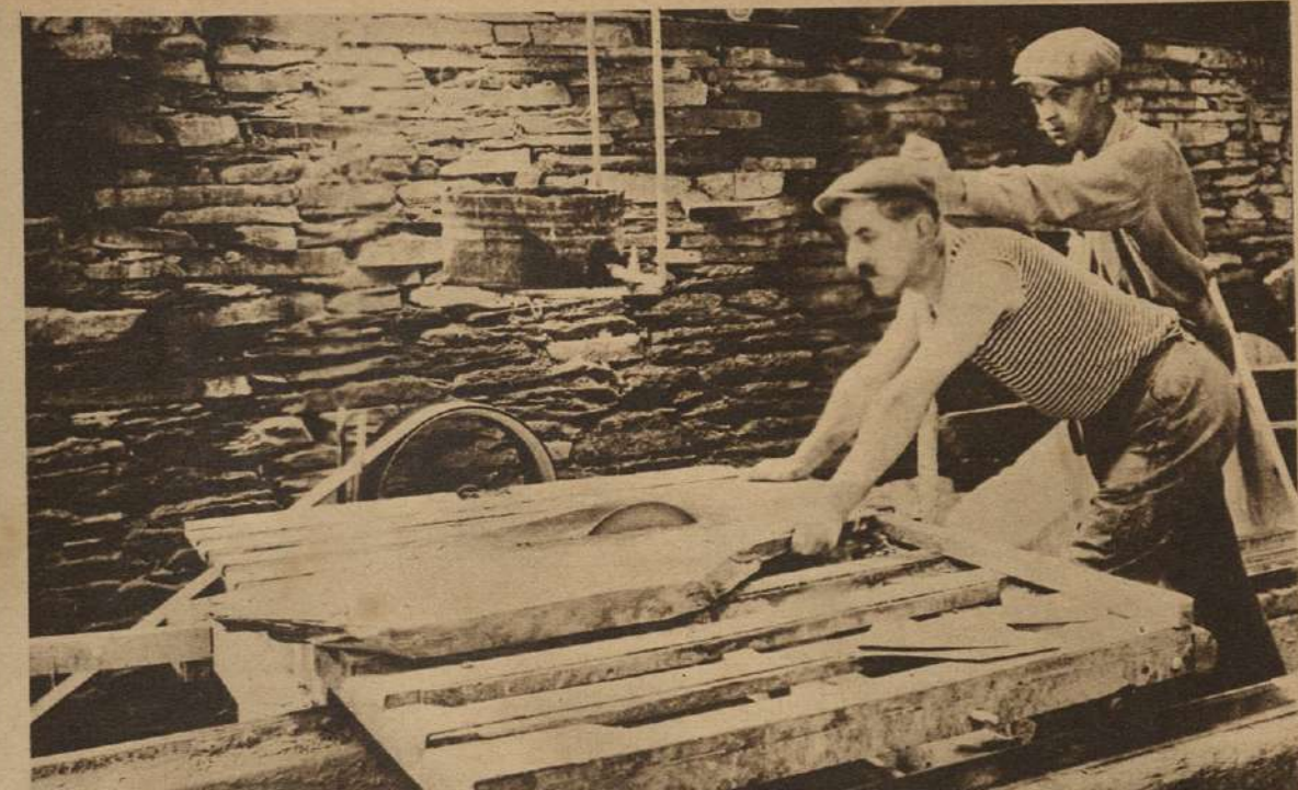
Obreros franceses cortando un gran trozo de pizarra en piezas que puedan manejarse con comodidad. El primitivo tanque de agua suspendido sirve para humedecer la sierra mecánica.
