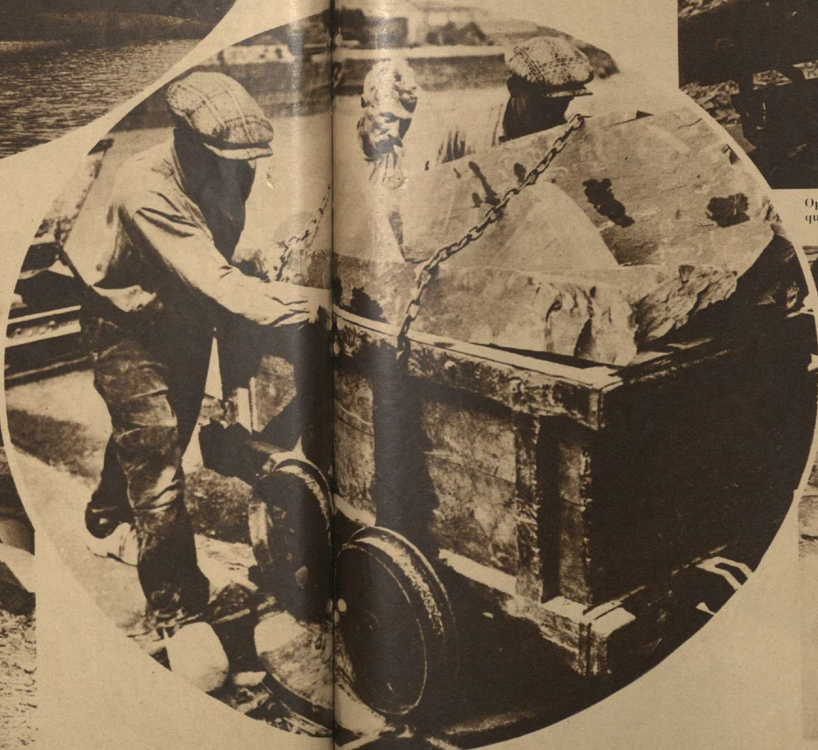
Aquí se ve una canchala con grandes trozos de pizarra que acaban de ser sacados de la mina. Se puede apreciar en esta y otras fotos, que los mineros usan zuecos.
