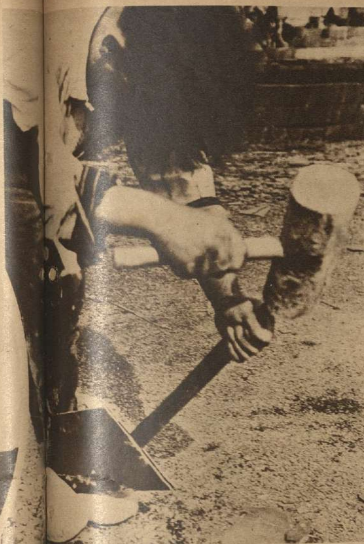
Un operario dividiendo una hoja de pizarra por el sistema tradicional. Consiste en emplear un cincel y un martillo de madera. Este trabajo es imposible con máquinas.
