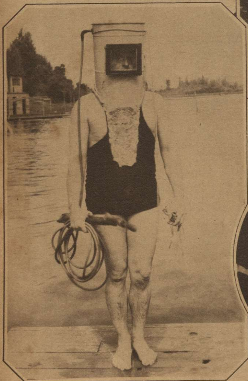
Escafandra hecha de piezas de un viejo automóvil, con la cual su creador, John D. Miller, de Gresham, Oregón, explora las profundidades de los ríos y de los lagos. Puede permanecer sumergido hasta 15 minutos.
