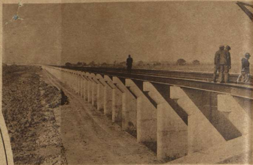
COMO SE PROTEGE UNA CIUDAD DE LAS INUNDACIONES. Para evitar el peligro de que el Mississippi inunde a Nueva Orleans, se ha construido un dique de cuatro kilómetros de largo, que permite el derrame de las aguas al pasar del nivel corriente.
