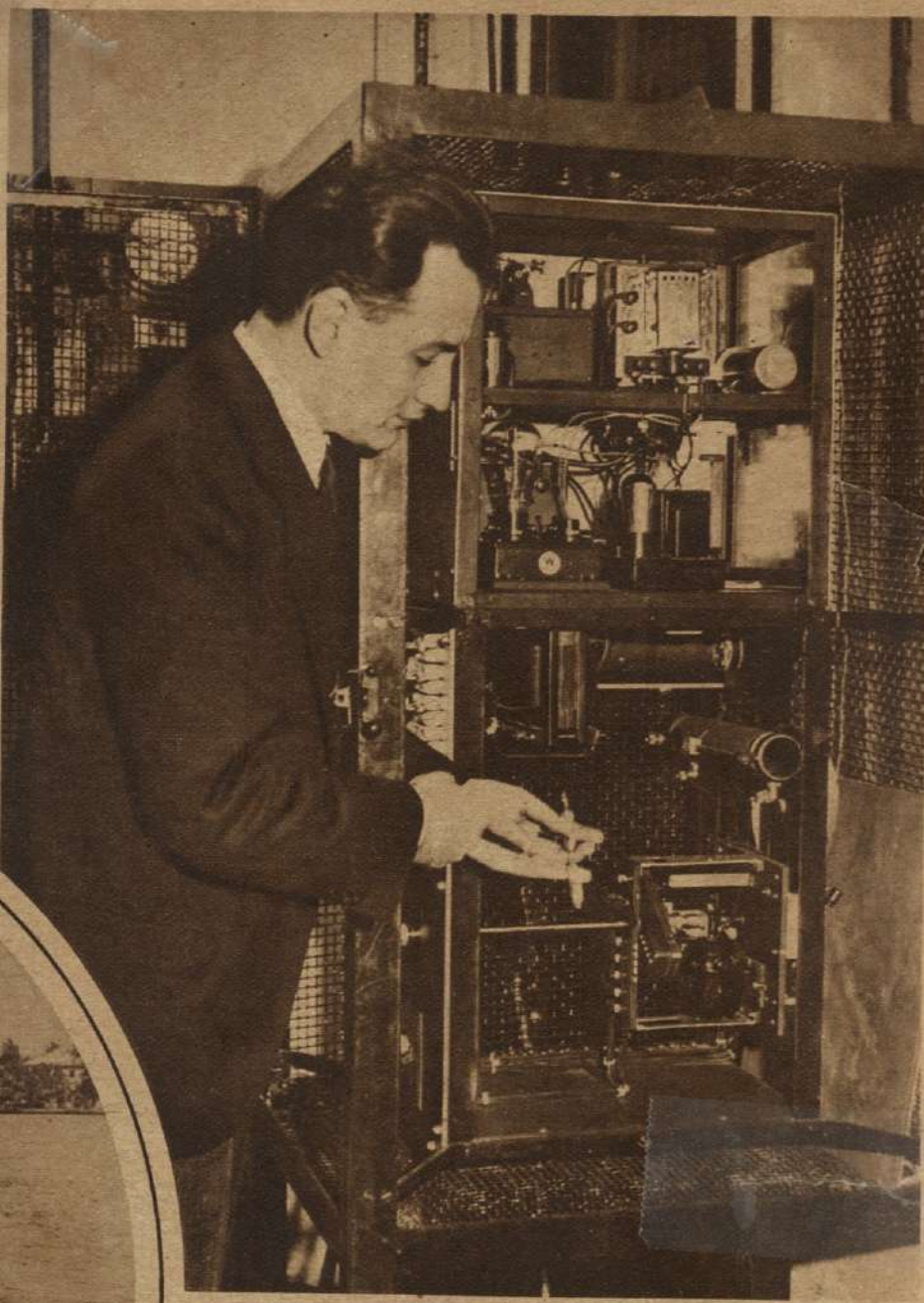
APARATO DE ALARMA CONTRA LOS INCENDIOS Y LOS LADRONES. —El invento de L. W. Skale, ingeniero rumano, ha causado sensación entre los técnicos por sus múltiples ventajas. En caso de incendio, tanto la temperatura, como el reflejo de las llamas ponen en marcha el mecanismo. Sus micrófonos ultra-sensibles, recogen el sonido más tenue, desafiando las artimañas de los ladrones.
