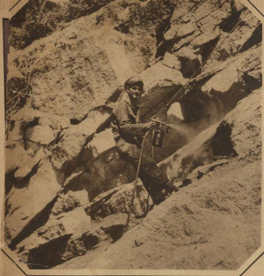
EN EL YOSEMITE NATIONAL PARK, donde se hicieron recientemente voladuras de rocas, este obrero se encarga de dar aspecto secular al granito, usando un pulverizador de negro de humo, espíritus minerales y aceite de linaza.
