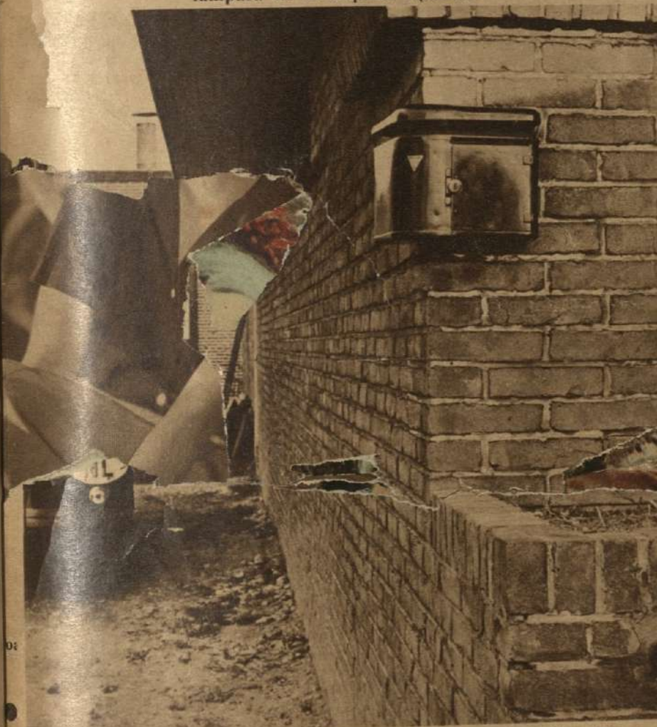
Otro tipo de lámpara para esquina, instalada en un edificio. Con ella puede saberse la ubicación de las diversas construcciones de una fábrica, que son invisibles desde las alturas.
