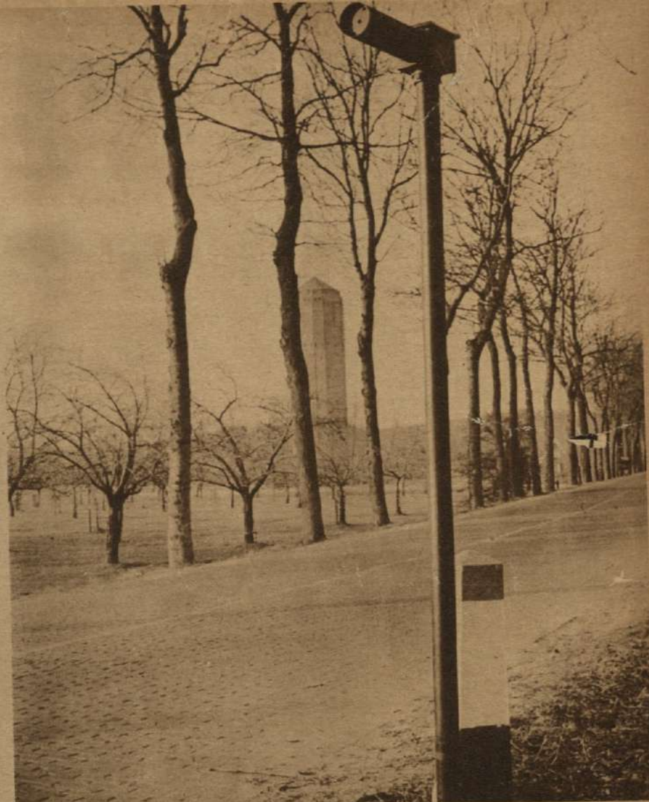
Lámpara de guía, del sistema de "Luz Invisible", cuyo haz luminoso alcanza a distinguirse desde el camino, pero no desde arriba, a una distancia como de 300 metros.
