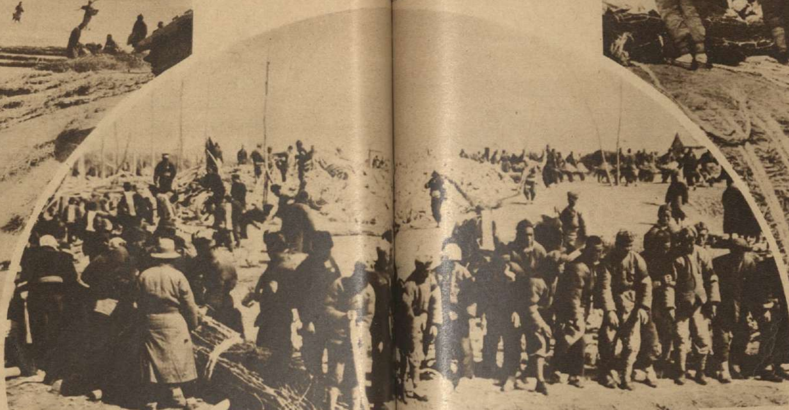
Los grandes haces de caña son atados con fuertes cables, y sirven de núcleo al dique.
