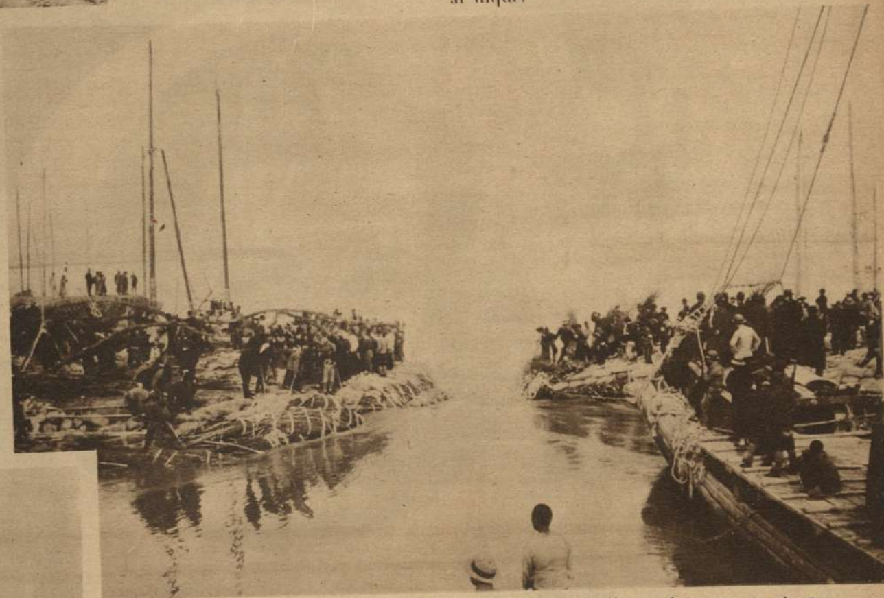
La obra del dique está a punto de terminarse, pues sólo queda una corta abertura que cerrar.
