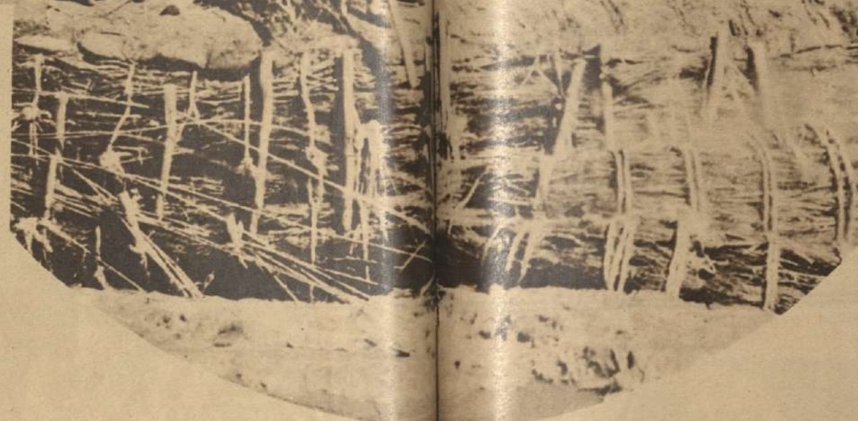
Se emplean fuertes cables de alambre para mantener las "salchichas" en sus
